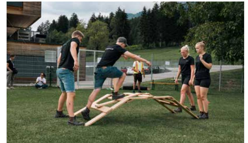
Bild: Bau der Leonardo-Brücke
